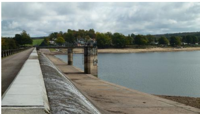
Barrage de Bouzey – Photographie DDT 88
