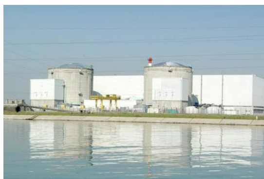
Centrale nucléaire de Fessenheim dans le Haut-Rhin Photographie issue de Wikipédia
