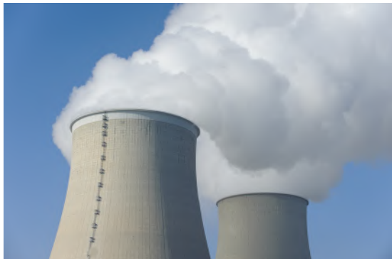
Centrale nucléaire de Nogent-sur-Seine dans l'Aube Photographie issue de la Photothèque du MEEM
